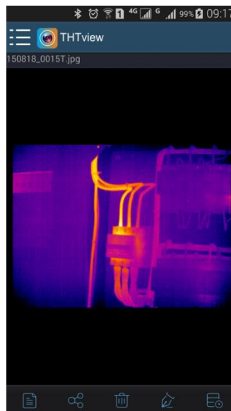
Abb. 43: Bild der geöffneten Galerie
