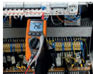
RCD Auslösezeit t_a und Auslösestrom I_a
