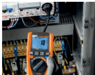
Impedanzmessung ohne RCD-Auslösung
