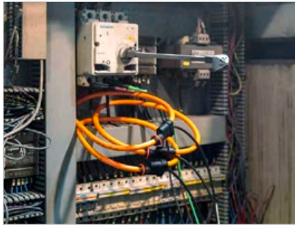
Messung Einsatz der flexiblen Stromwandler
