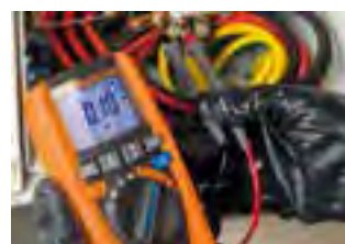
Durchgangsprüfung von Schutzleitern.
