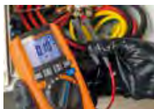
Durchgangsprüfung von Schutzleitern.
