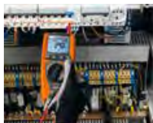
RCD Auslösezeit t_a und Auslösestrom I_a
