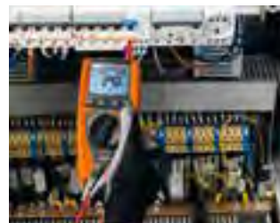
RCD Auslösezeit t_a und Auslösestrom I_a
