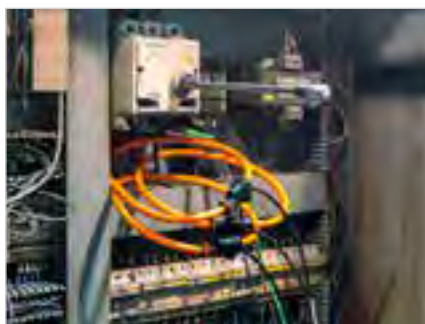
Messung Einsatz der flexiblen Stromwandler
