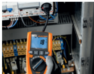
Impedanzmessung ohne RCD-Auslösung
