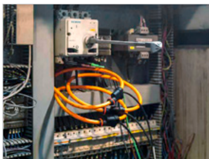
Messung Einsatz der flexiblen Stromwandler
