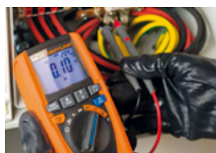
Durchgangsprüfung von Schutzleitern.
